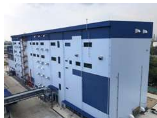
IPI敷地内に竣工したTIAFのエアバッグ用ナイロン原糸生産工場
