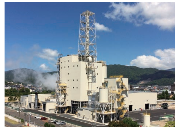
敦賀グリーンパワー(株)のバイオマス発電所 主燃料は木質チップ、発電出力は37MW
