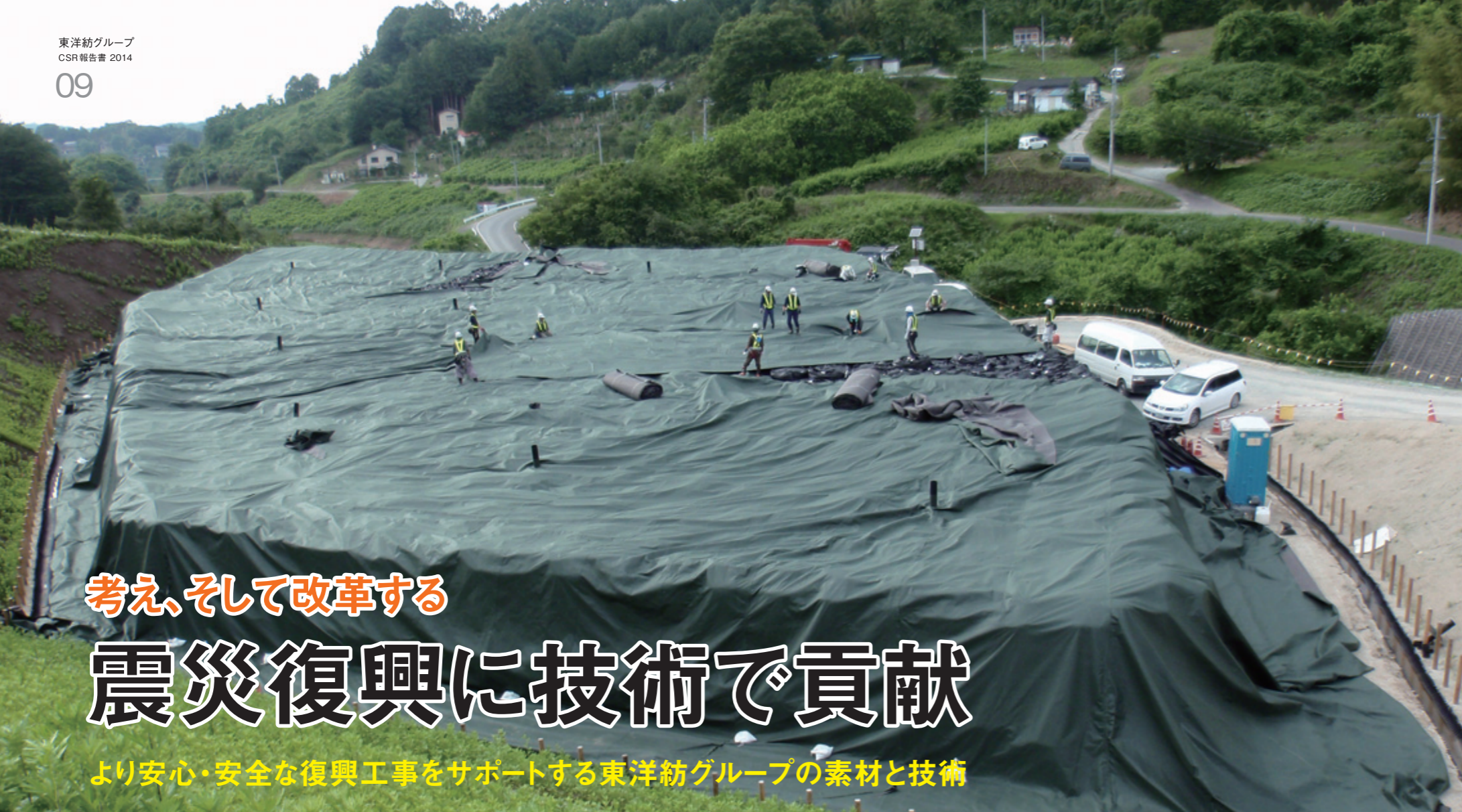
除染廃棄物の仮置場を覆うシートとして使われる「ボランス®キャッピングシート」(福島県)
