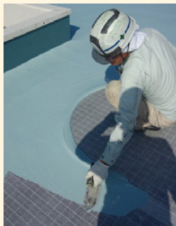
通気緩衝シートへの防水材塗工の様子
