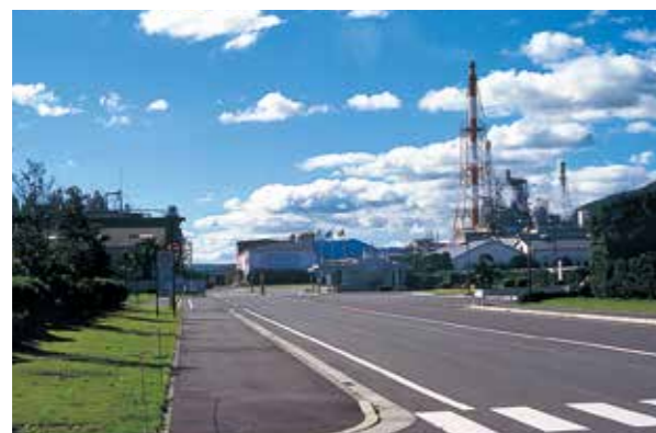
環境に配慮した製品および生産活動 岩国事業所
