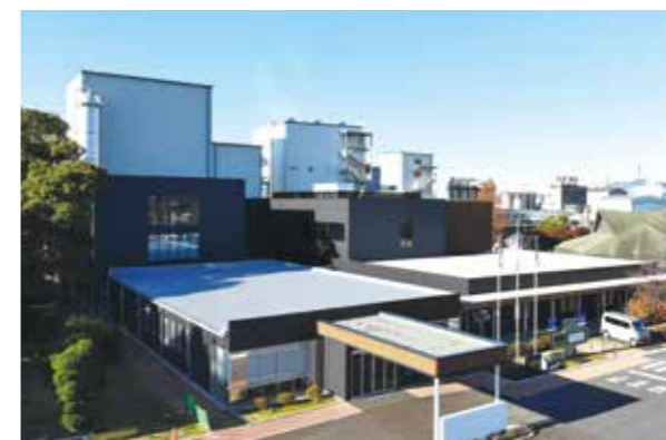
フィルム事業の基幹生産工場 犬山工場
