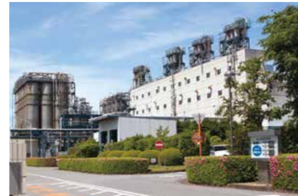
フィルム生産の新たな拠点 宇都宮工場
